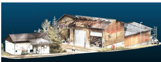
Abb. 5: Punktwolke aus terrestrischem Laserscanning
