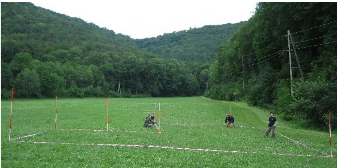
Abb. 9: Seilbahnabsteckung der Talstation
