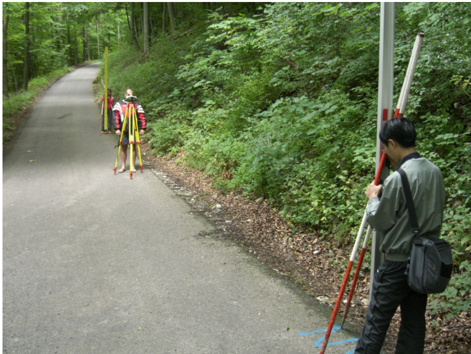
Abb. 6: Feinnivellement
