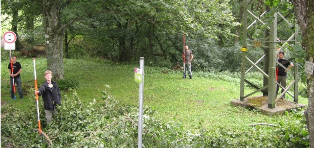
Abb. 8: Seilbahnabsteckung der Bergstation
